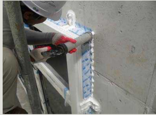
창호 설치 부분 외부 쪽에 실리콘 밀폐 보강
