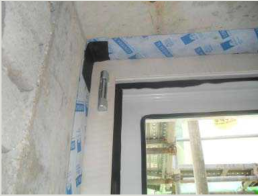
창호 설치 부분 내부 쪽에 기밀테이프 시공
